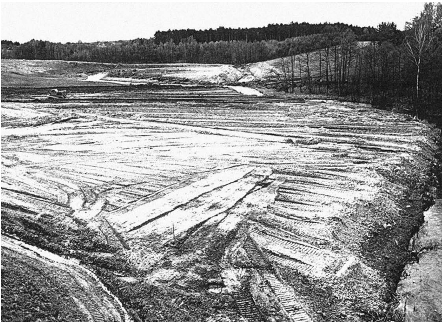
Budowa Zabrodzia, 1985 r.
