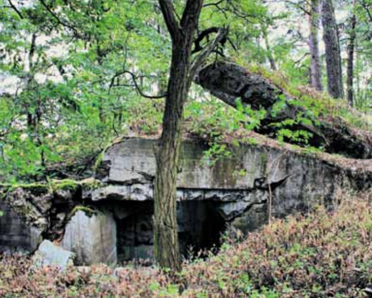
Umocnienia Wału pomorskiego – pozostałości w Przysiece
